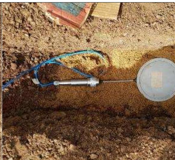
**Base:** Instalação da célula de pressão na interface da sub-base/base
