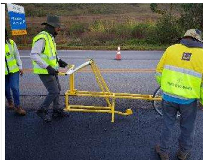
**Revestimento:** Ensaio Merlin
