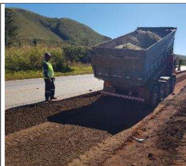
**Base:** Distribuição de material usinado – mistura de rejeito, brita 0 e brita 1 – (p/ camada – 1: 15 cm)
