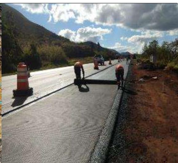
**Revestimento:** Instalação de Geogrelha
