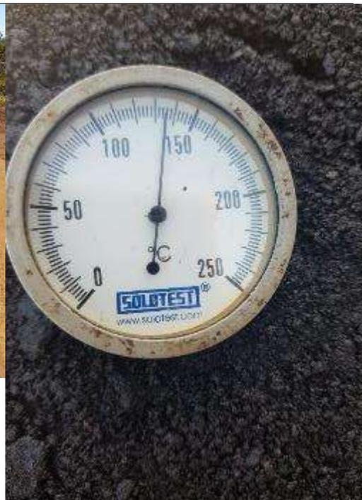
**Revestimento:** Controle de Temperatura do CBUQ
