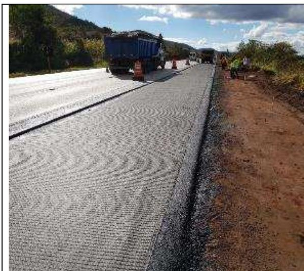
**Revestimento:** Instalação de Geogrelha
