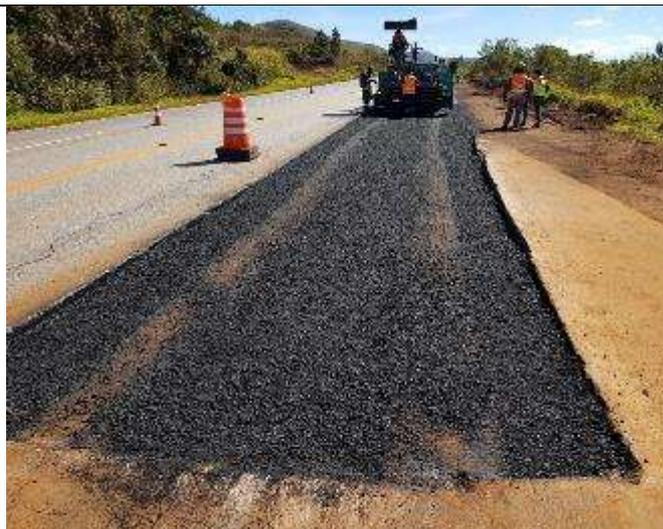
**Salgamento:** Lançamento de uma fina camada de massa asfáltica não regularizada apenas visando melhor aderência para os equipamentos
