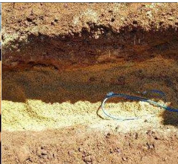
**Sub-base:** Instalação do sensor de pressão – Interface sub-base/subleito
